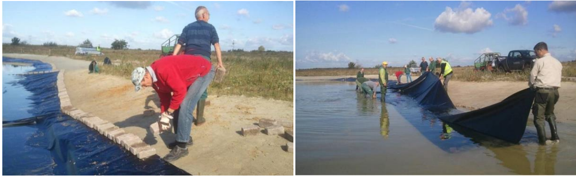
Figure 21 : Pose de bâches en plastique dans le cadre d' expérimentations menées aux Pays-Bas . © RINSE
