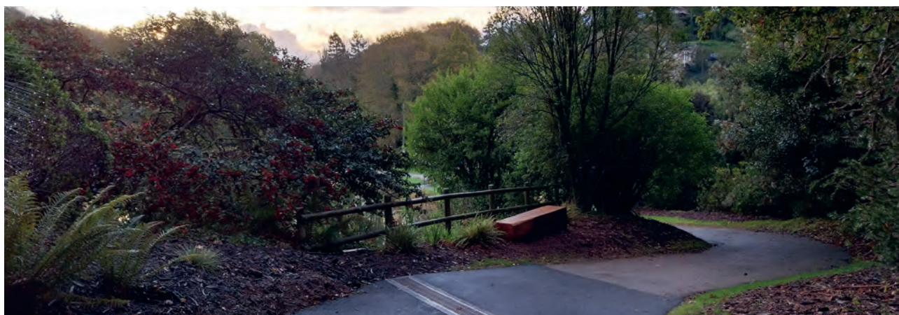
Réfection d'allées et pose de bancs
