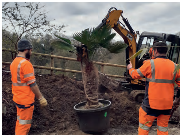
Réaménagements arbustifs autour des serres pédagogiques
