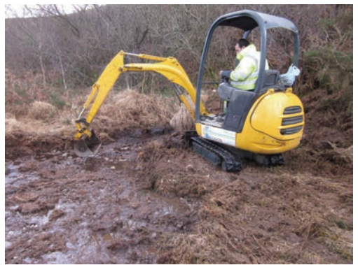
Figure 5 : Chantier d'étrépage mécanique au Menez Hom (photo A. Lieurade, CBN de Brest)
