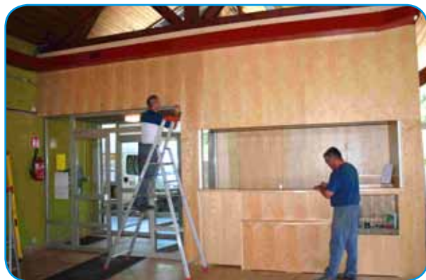
Rénovation de l'espace d'accueil du public
