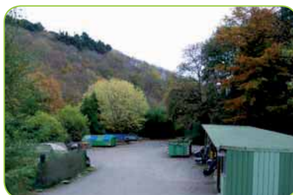
Locaux techniques et hangar
